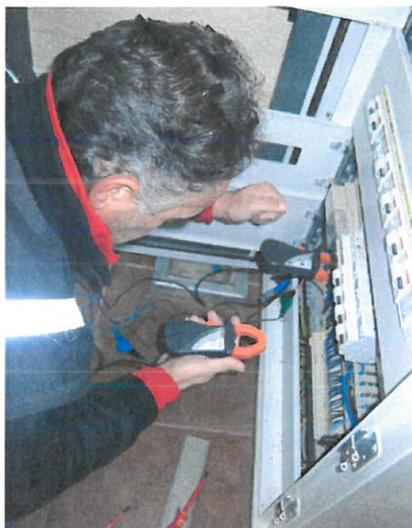
*Figura 3.28 - Installazione dell'analizzatore nel quadro principale*
