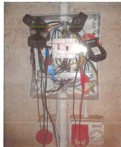
Figura 3.25 - Denocciolatore e coclea di trasporto della sansa, Installazione dell'analizzatore nel quadro del denocciolatore
