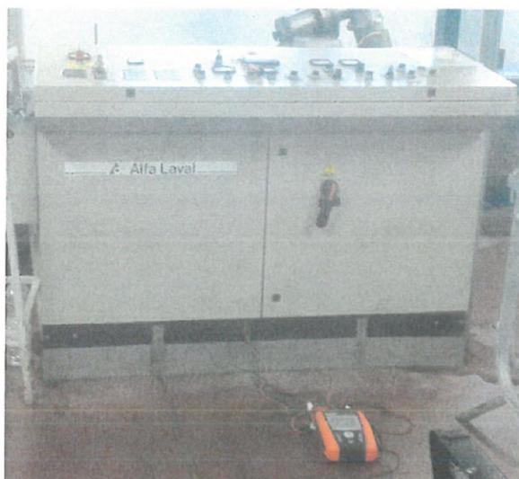
*Figura 3.34 - Quadro comandi con analizzatore installato*
